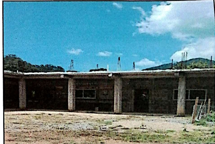
Foto 4: Reparación de sistema eléctrico
