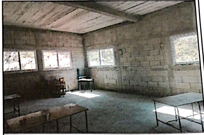
Foto 2: Reparación de repello y cernido de paredes
