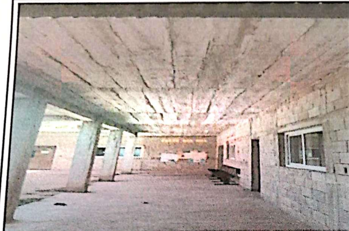
Foto1: Reparación de repello y cernido de paredes
