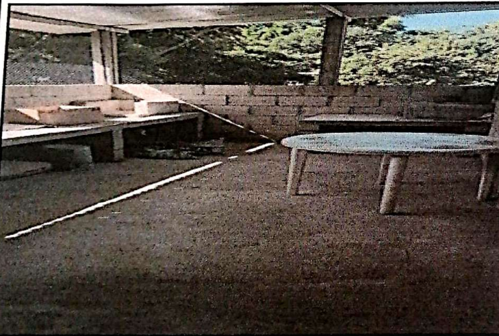
Foto 3: Reparación o sustutución de área de cocina
